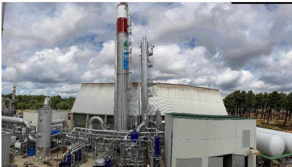
Ilustración 2: planta de captura y depuración de CO 2
