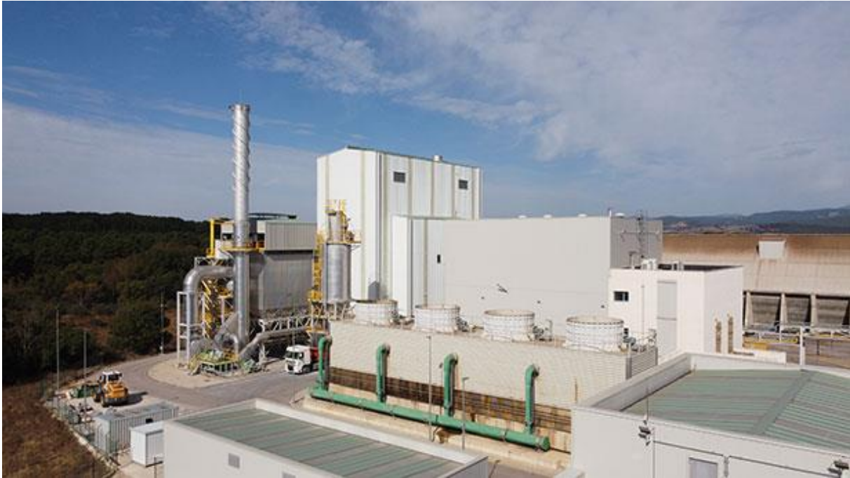
Figura 3: Planta de generación de electricidad y sistema de separación de gases (Carbueros Metálicos)
